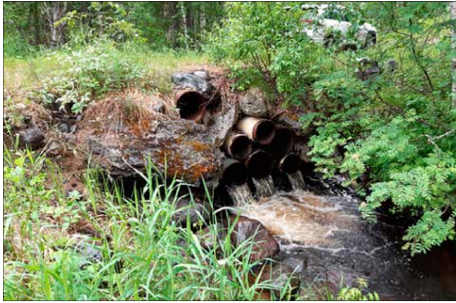
Kuvapari täydellisen vaellusesteen muodostavasta tierummusta ja esteettömästä rummusta vaellusesteen poiston jälkeen. Kohteeseen vaihdettiin puroon mitoitettu rumpu ja sen alapuolta kynnystettiin, jotta rumpuun saatiin oikea vedenkorkeus ja virtausnopeus.
