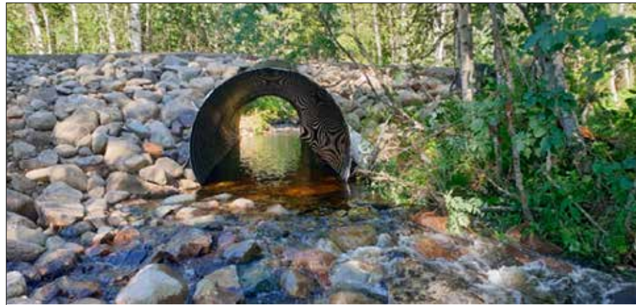
Kuvapari täydellisen vaellusesteen muodostavasta tierummusta ja esteettömästä rummusta vaellusesteen poiston jälkeen. Kohteeseen vaihdettiin puroon mitoitettu rumpu ja sen alapuolta kynnystettiin, jotta rumpuun saatiin oikea vedenkorkeus ja virtausnopeus.
